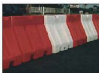
Fila di delineatori di corsia flessibili per separare le corsie di marcia deviate
