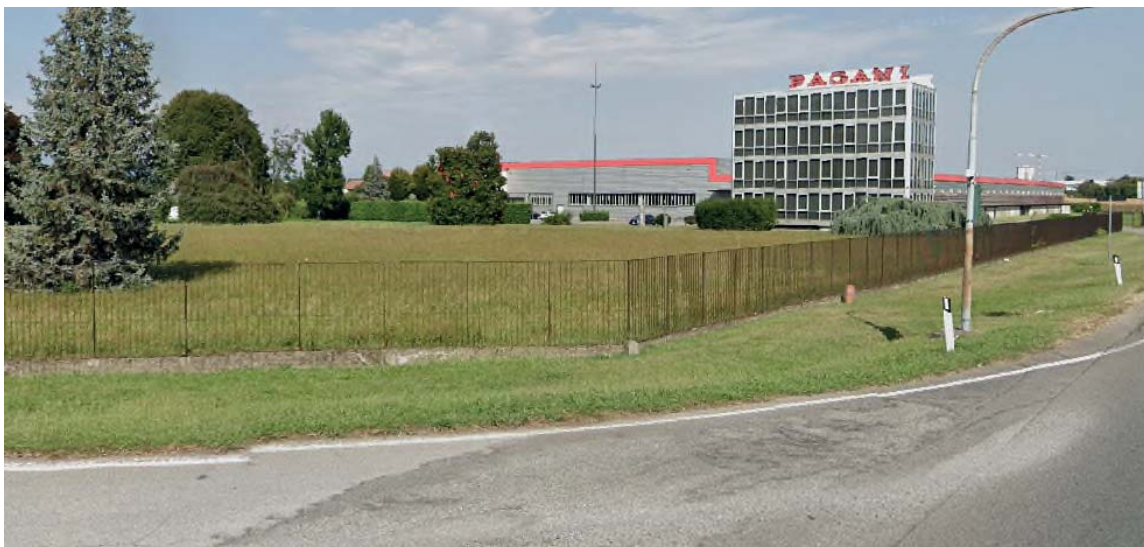
Recinzione proprietà stabilimento Pagani in interferenza con un tratto di pista ciclabile
