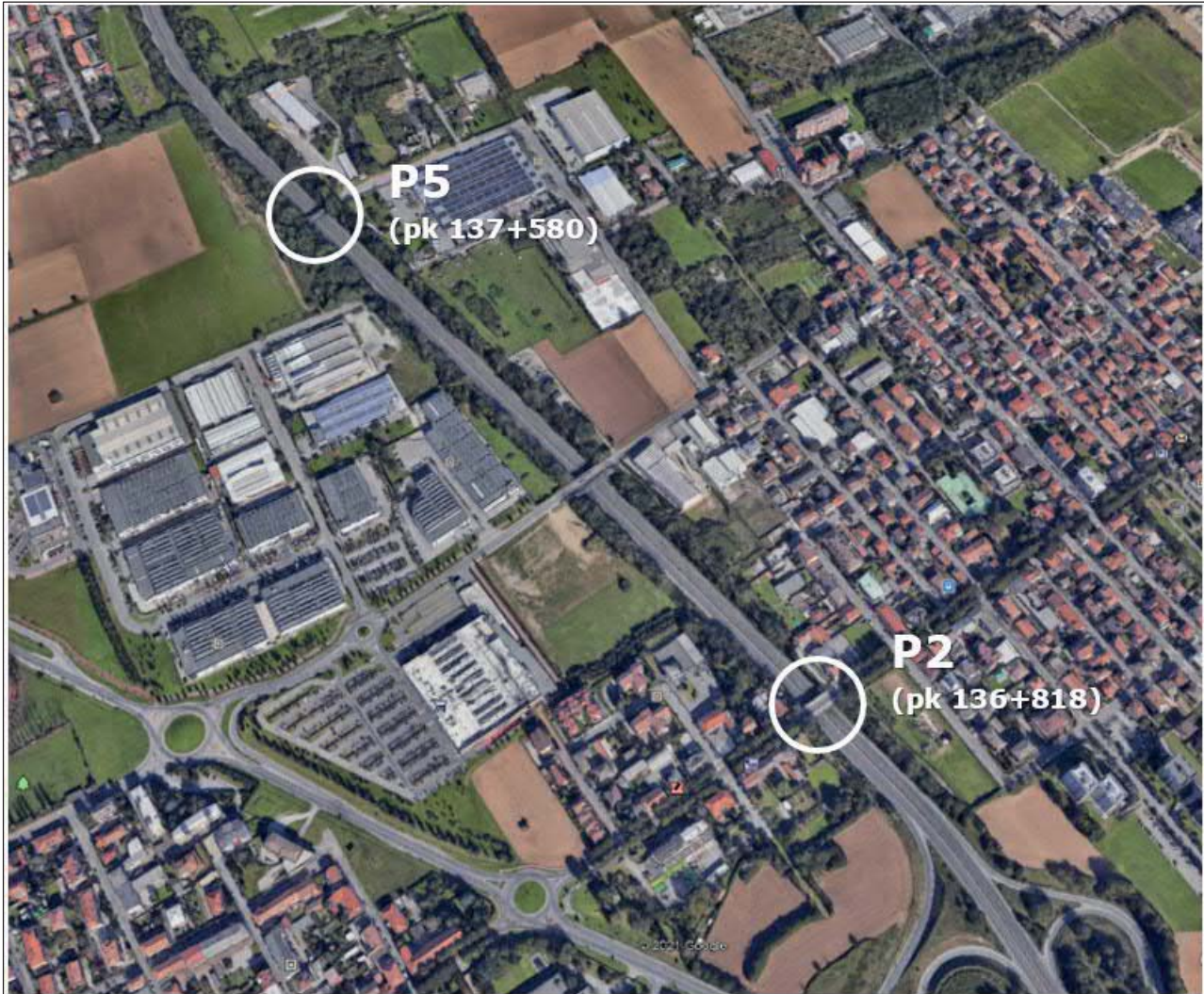
Figura 1 – Individuazione dei due manufatti P2 e P5 posti lungo la SP ex SS n. 35
